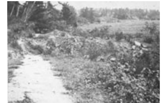
村森黒郡川田西縣形山(四) 図11(B4) ブ及び二間八七トコルス動移ヲ部一ノ路道テシ壊崩腹山
