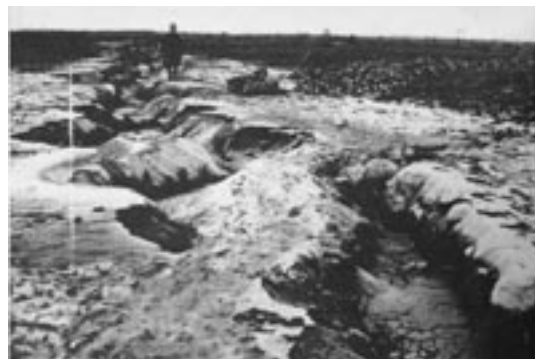
図ノ裂亀地土村越砂郡海飽縣形山(五十) 図22(B15)
