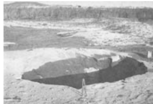
(尺八徑孔) 陥落ノ地砂テ於ニ村浦野宮郡川田西縣形山(三) 図10(B3)
