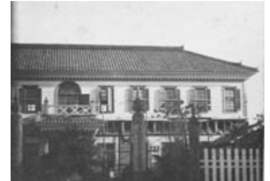
損破ノ所役郡海飽町田酒(九十) 図26(B19)
