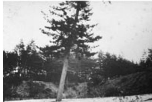
図ノ層断地砂籍地村中濱郡川田西縣形山(九) 図16(B9) ス没埋ヲ部下ノ水樹テシ出流ヲ砂ツ尺十二フルス落陷ノ地
