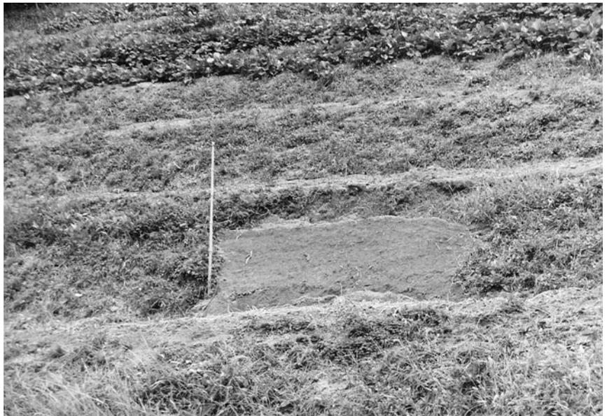
b. 土手の崩壊。いわゆるツエヌケ。写真b.cともに1990年代前半の倉橋町内。休耕畑が多くなっている。
