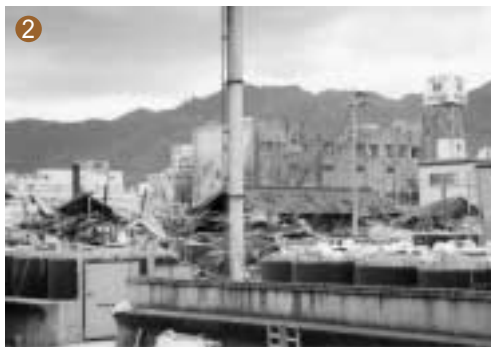
2 倒壊した酒蔵（兵庫県神戸市）
