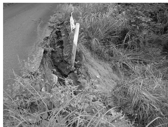
b) カキバヤシノタニを横切る林道脇の土砂崩れ (2004年9月 筆者撮影)
